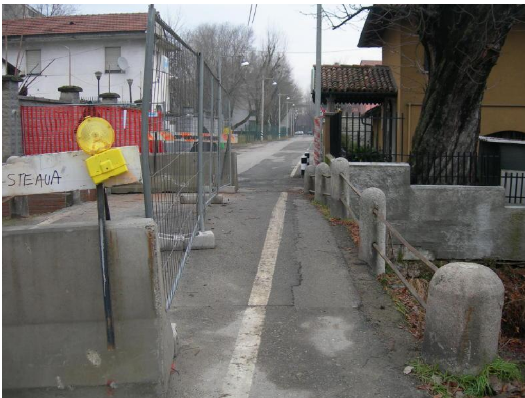
Foto 6 e 7 – Il ponte storico in via Campazzino. Stato di fatto durante i lavori in data 09.01.2008: è stato creato un muricciolo in mattoni e pare vi sia l'intenzione di eliminare i caratteristici panettoncini con balastra.
