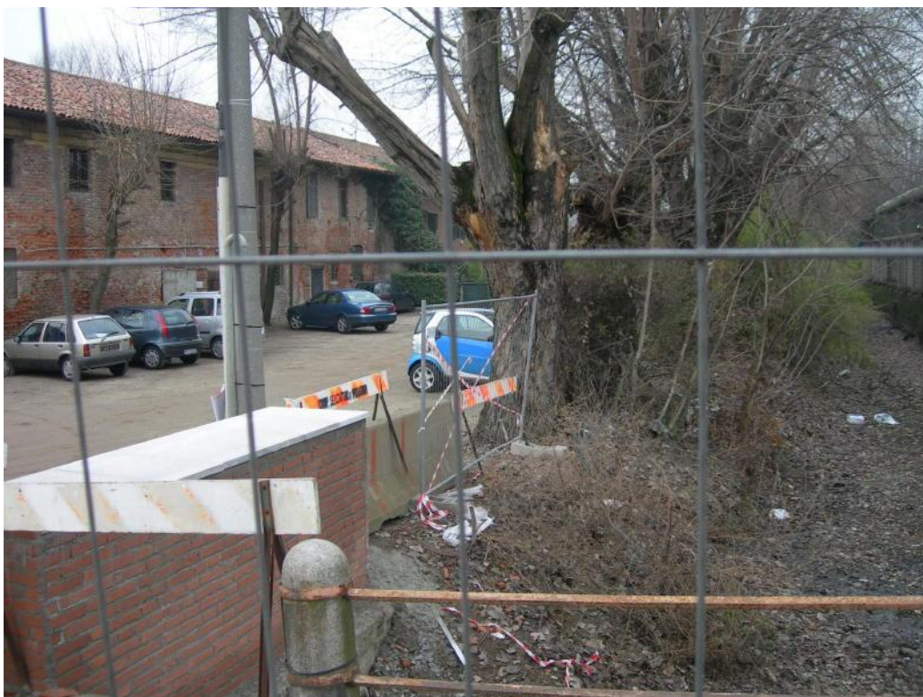
Foto 4 e 5 – Il ponte storico in via Campazzino. Stato di fatto durante i lavori in data 09.01.2008: è stato creato un muricciolo in mattoni.
