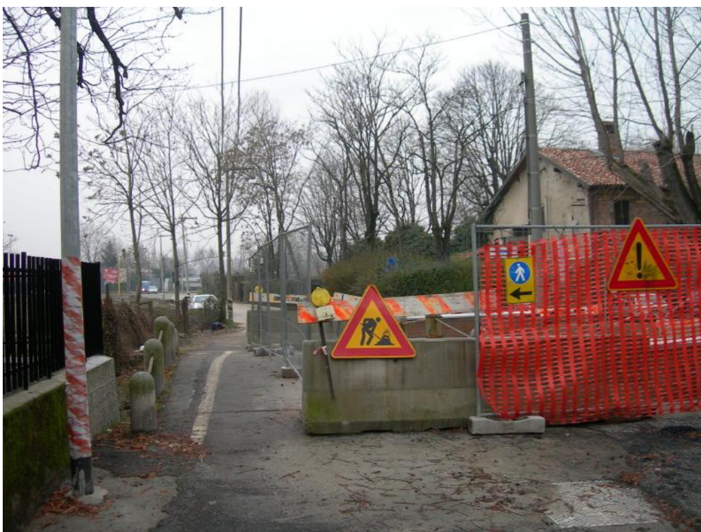
Foto 2 – Via Campazzino e i lavori in corso sul ponte storico.
