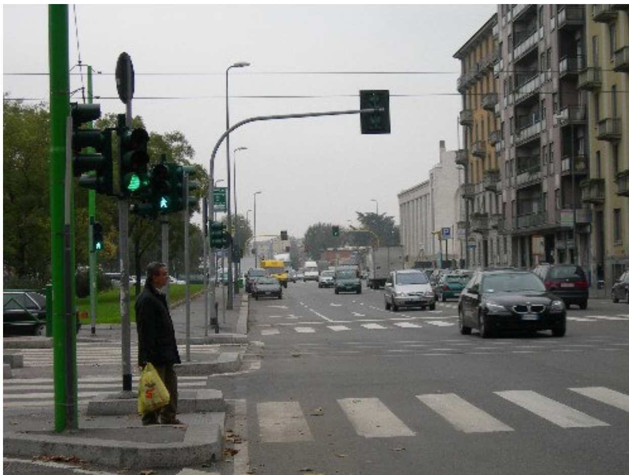
Foto 3 – Incrocio di viale Cermenate con via Volvinio (a destra) e via Pezzotti (a sinistra): la segnaletica orizzontale della corsia di sinistra riporta la possibilità di svolta a sinistra per immettersi in via Pezzotti, ma nell'impianto semaforico non è prevista l'opportuna segnaletica del tempo per la svolta a sinistra che risulta quindi assai ardua.
